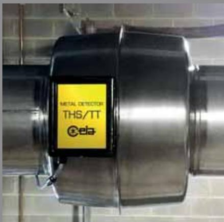
Le détecteur de métaux **THS/TT** est un dispositif pour la détection de polluants métalliques éventuellement présents dans les lignes de production sur conduites (par exemple du type pneumatique)
